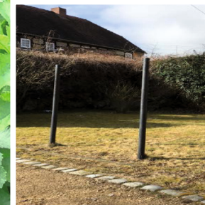
hier entsteht ein Grillplatz
